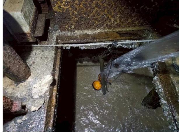
ในระหว่างการสูบ ใช้หัวแฉะตะกอนที่เกาะติดขอบบ่อ
