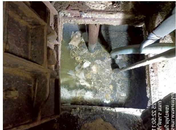
ในระหว่างการสูบ ใช้หัวเจาะตะกอนที่เกาะติดขอบบ่อ
