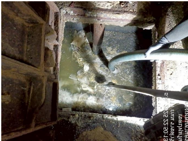
ในระหว่างการสูบ ใช้หัวเจาะตะกอนที่เกาะติดขอบบ่อ
