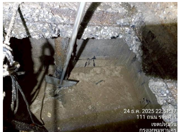
ในระหว่างการสูบ ใช้หัวแชะตะกอนที่เกาะติดขอบบ่อ
