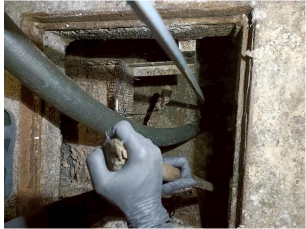
ในระหว่างการสูบล้างหัวตะกอนที่เกาะติดขอบบ่อ
