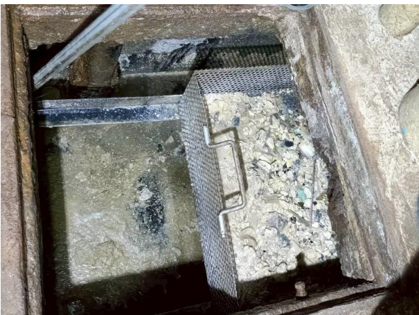
ในระหว่างการสูบ ใช้พลั่วแซะตะกอนที่เกาะติดขอบบ่อ
