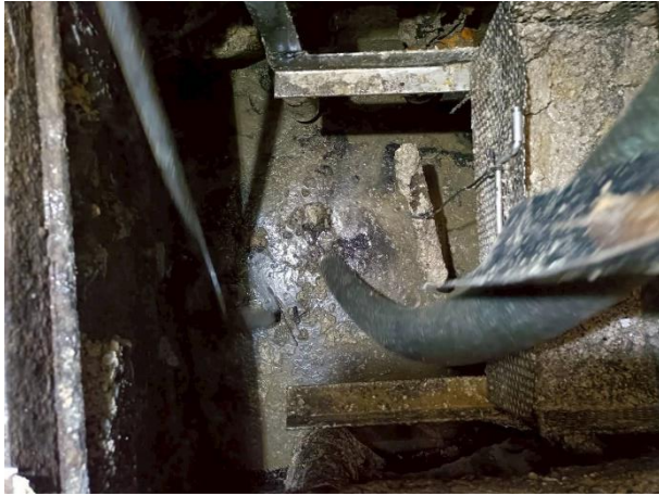
ในระหว่างการสูบล้างหัวตะกอนที่เกาะติดขอบบ่อ
