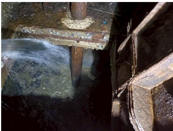
ในระหว่างการสูบ ใช้หัวเจาะตะกอนที่เกาะติดขอบบ่อ
