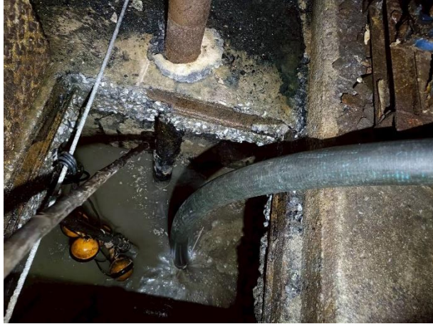
ในระหว่างการสูบ ใช้หัวแฉะตะกอนที่เกาะติดขอบบ่อ
