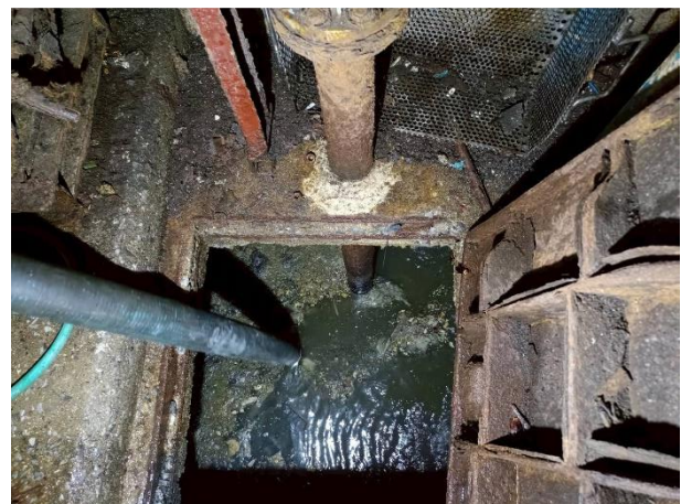
ในระหว่างการสูบ ใช้หัวเจาะตะกอนที่เกาะติดขอบบ่อ
