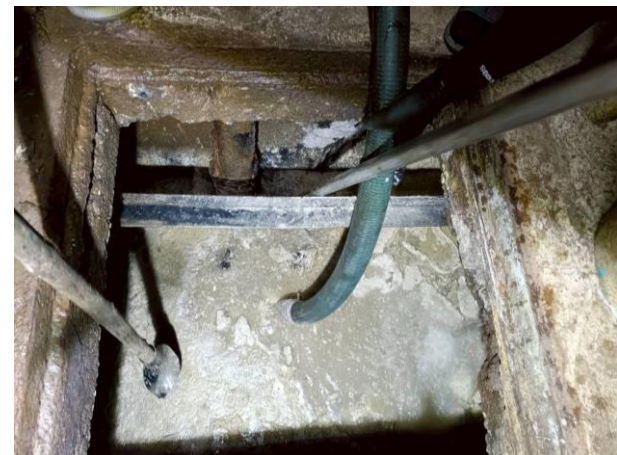
ในระหว่างการสูบ ใช้พลั่วแซะตะกอนที่เกาะติดขอบบ่อ
