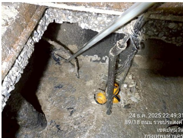
ในระหว่างการสูบ ใช้หัวแชะตะกอนที่เกาะติดขอบบ่อ
